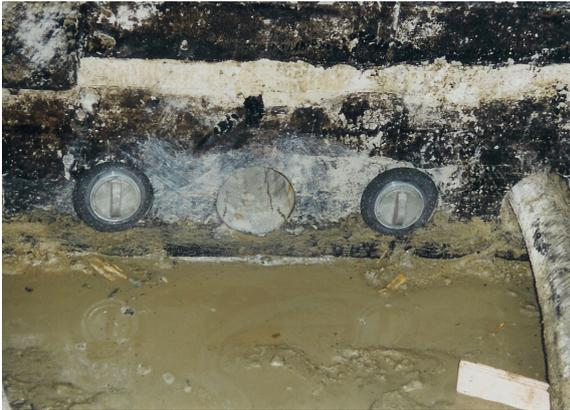
Mit der MD4 können unbelegte Mauerbohrungen und Durchführungen schnell und einfach dauerhaft abgedichtet werden.
